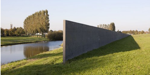
Eén van de twee 200 meter lange betonnen muren van Sea Level
